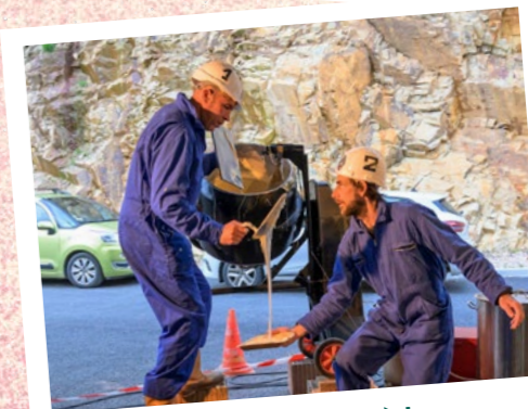
Murat-sur-Vèbre : Sous la Halle
